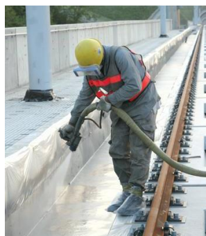
Figura 12.8.4.2.6.a - Applicazione a spruzzo della membrana impermeabile
