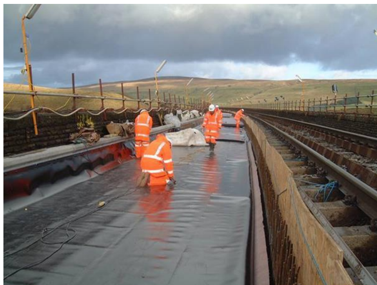
Figura 12.8.4.2.2 - Lavorazione con il 2° binario in affianco sostenuto
